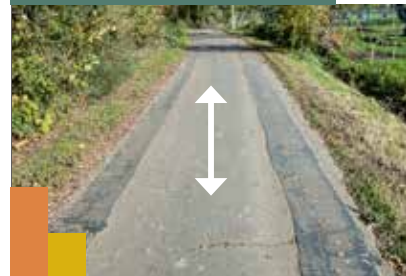
VERHARDE TRAGE WEG 'laagje asfalt sinds 2de helft 20ste eeuw'
